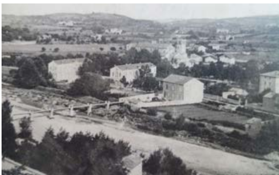
La passerelle aboutit rive droite à côté des écoles
