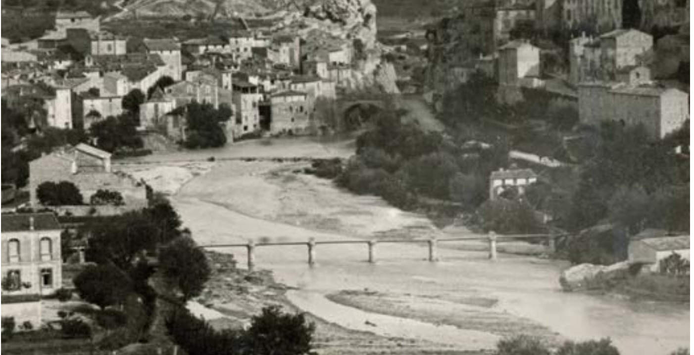
Sur cette photo du début du XX e siècle, la passerelle, fragile, semble attendre inquiète qu'une crue monstrueuse débouche sous le pont romain.
