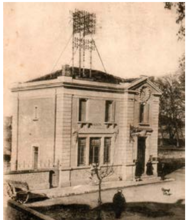
La poste et ses antennes
